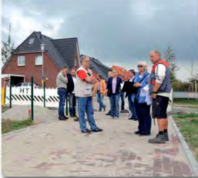
Die Abnahme der Erschließung Fotos: Ki
