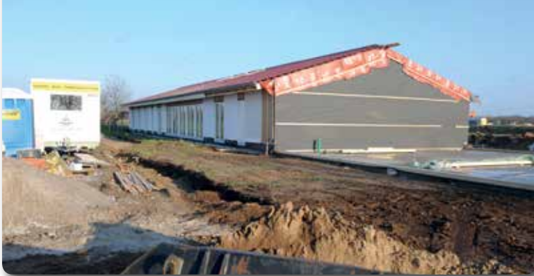
Die Bauzeit ist fast abgeschlossen. Fotos: Ki
