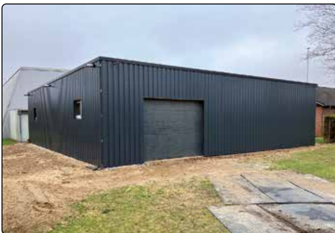
Multifunktionshalle: Der Baustand.
