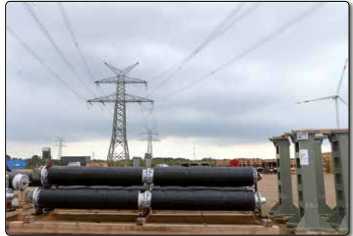
Die Bauarbeiten laufen. Fotos: Ki.
