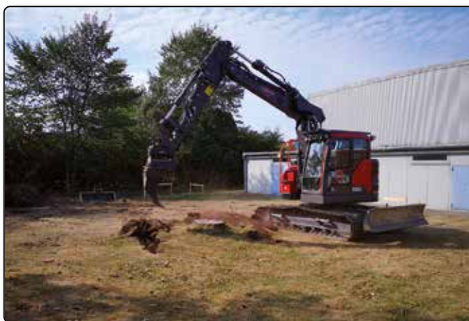
Der Bagger rollt.
