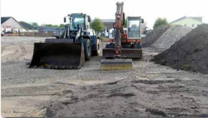
Die „Aldi“-Fläche ist eingeebnet
