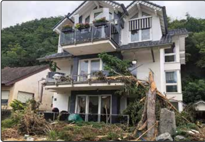
Das zerstörte Haus in Dernaau
