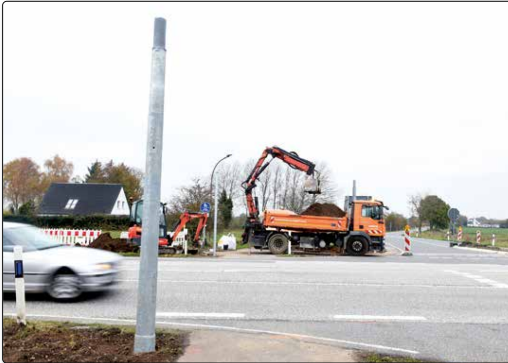
Bauarbeiten in Haurup-Hoffnung.
