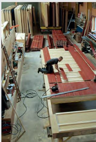
Damit es schnell geht, werden Innen- und Außenwände in einer Halle vormontiert. © Tim Boehme
