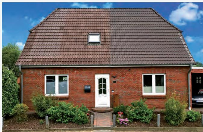
Im Vergleich: links nach der Reinigung, rechts nach der Beschichtung.
