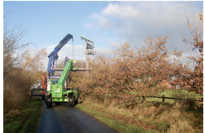
Dieses Bild zeigt den Abbau des letzten 20.000 Volt Mastes in unserer Gemeinde bei Dreldorf Petersburg-Mühle am 17.11.2016.
