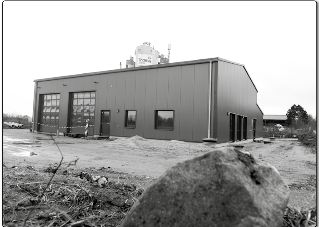
Das Gerätehaus an der Europastraße ist fast fertig.
