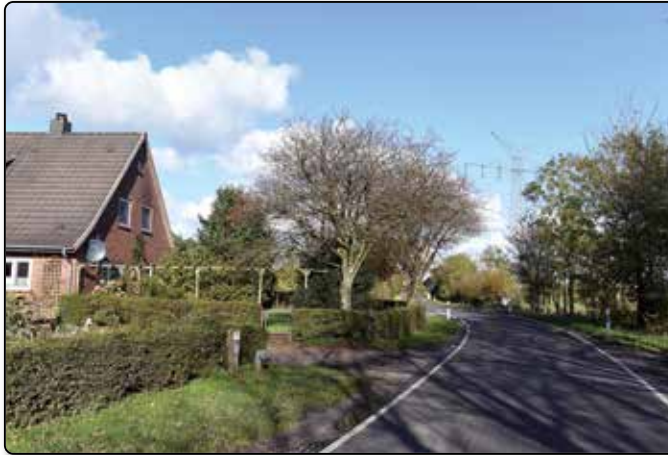
Die bestehende 220-Kilovolt-Leitung bei Handewitt-Kolonie, schön versteckt.
