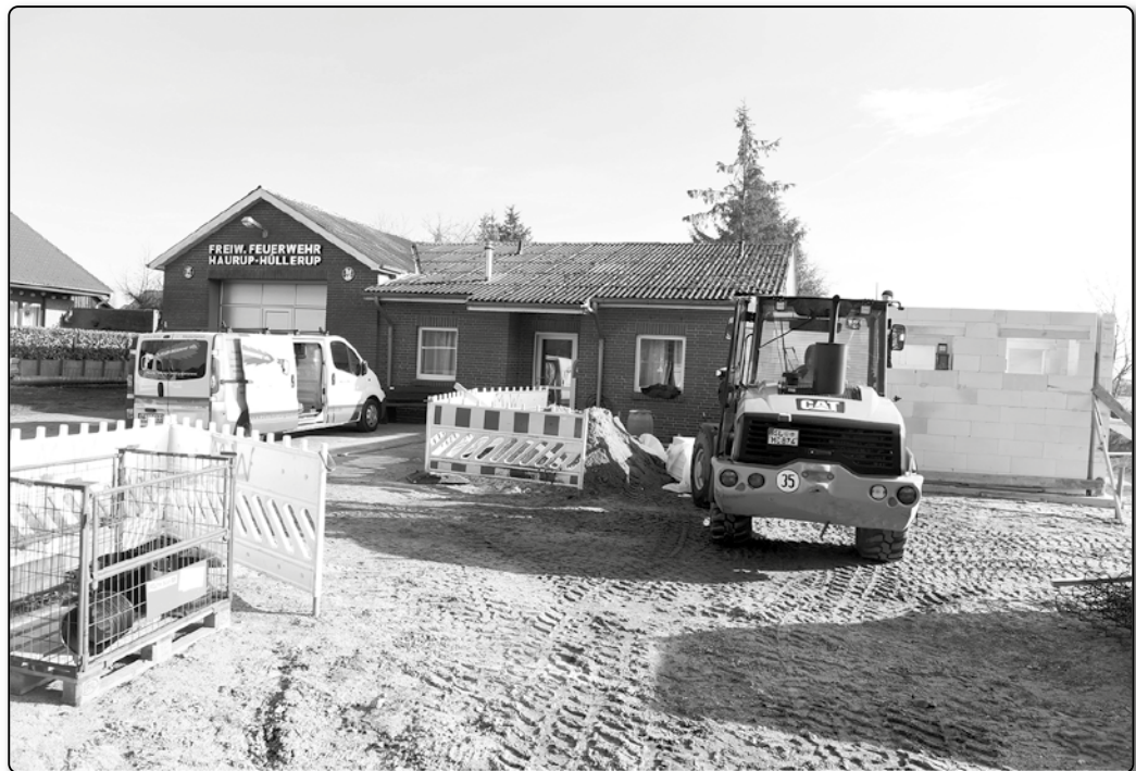
Am Hauruper Gerätehaus wird gebaut.
