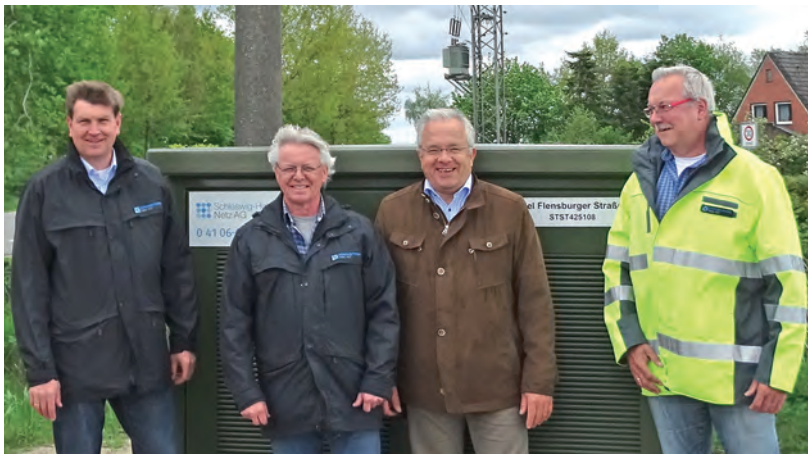
Sie freuen sich über die fertiggestellte Maßnahme im Bereich des Stromnetzes: Sönke Nissen von links), Bernd Dittmann (beide SH Netz), Högels Bürgermeister Ernst-Peter Carstensen sowie Ralf Szymkowiak (ebenfalls SH Netz). Foto: Felix Middendorf
