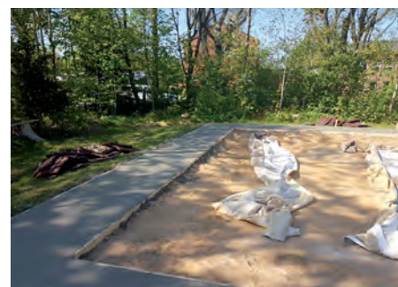
Der Steg für die Platten wird hergerichtet
