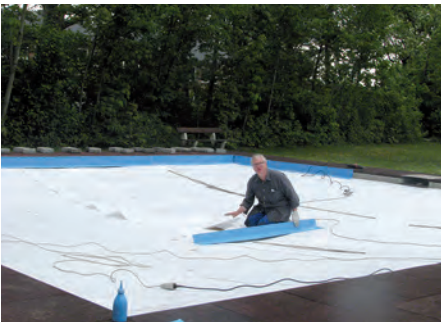
Die Fa. Dammann hat das Vlies ausgelegt und verlegt die Kanten
