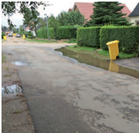
Anliegerstraße vor den Bauarbeiten...
