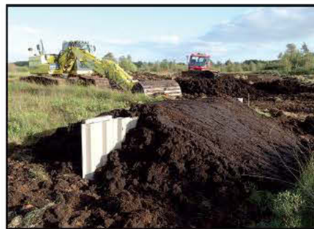
Spundwand mit Abdeckung
