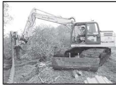
Spundwand setzen
