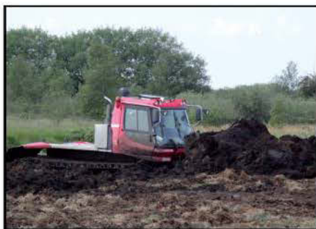
Moorraupe im Einsatz
