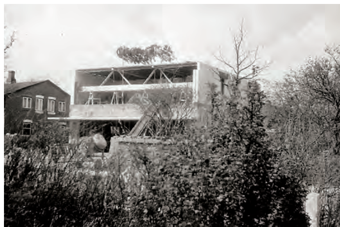
Burmeister wird größer. Der kleine Laden war den vielen Kunden in Viöl nicht mehr gewachsen. Ein Neubau mit Wohnung über dem Ladengeschäft entstand 1967.
