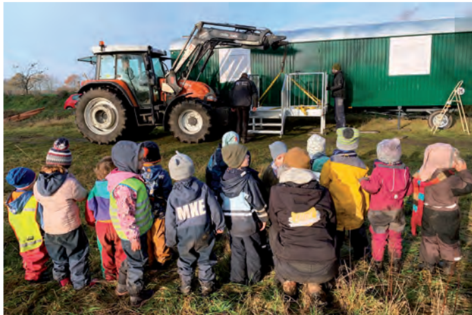
Aufmerksam bestaunen die Kleinen, wie eine Treppe vor ihrer Schutzhütte installiert wird. Fotos Levke Wittmaack
