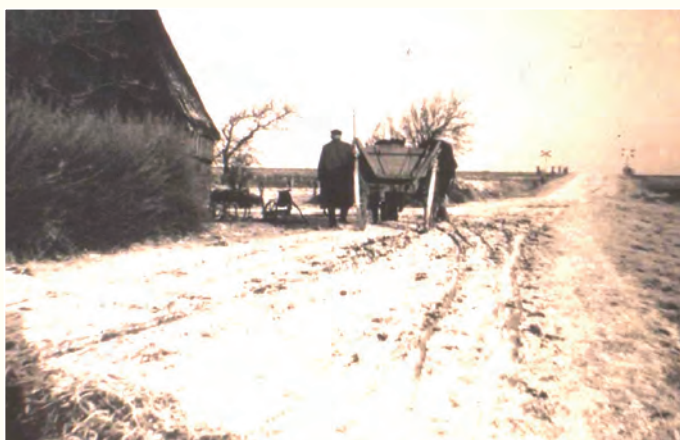
Das Bild links zeigt den Bahn-übergang auf Tayswatt mit den Andreas-Kreuzen. Links das Haus Tayswatt 1, damals Broder Martensen
