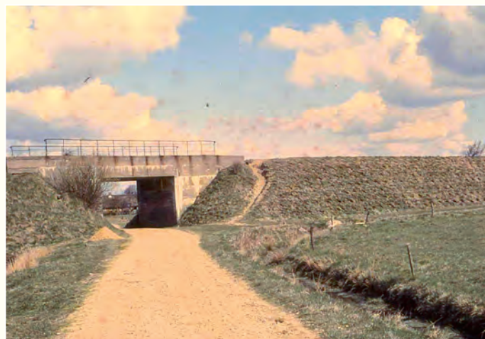
Der große Tunnel, sichtbar das Haus Osterweg 12
