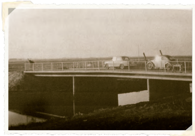
Die neue Engebrücke
