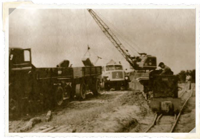
Bau des Ostenaudeiches
