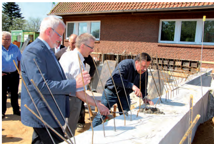
Fachkundig mauerten (v.l.) Thomas Hansen, Gerd Carstensen und Hargen Johannsen die Dokumentenrolle ein
