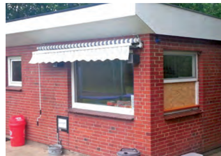
Mit einer Spanplatte wird das Kiosk-Fenster am Drelsdorfer Schwimmbad nach dem Einbruch vorläufig gesichert. Die Täter verursachten einen Schaden von rund 3000 Euro.
